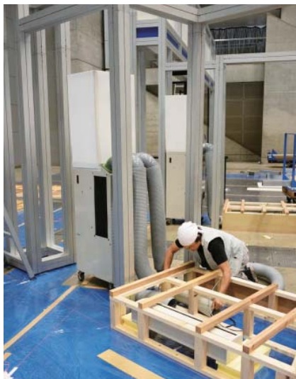
グレーのパイプがスポットクーラー。このパイプが通る台を作ってラックを置き、下から冷気を吸い込む。台の中に見えるクリーム色の箱がエアカーテン。床下から天井へのエアフローを作る
