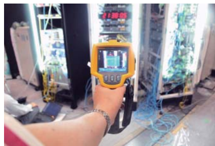
エアフローや熱だまりは見えないので、サーモグラフィを使って温度を調べて管理する
