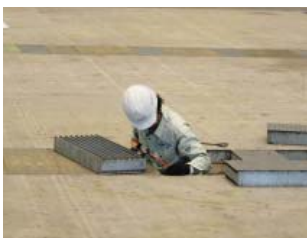
13 会場内では最初に電源ケーブルの施設作業が行われる。ピットはけっこう深いので、下手に落ちると大けがのもとに
