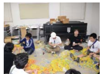
19 ケーブルを巻き巻きする作業。これは極々ほんの一部。展示会場内の出展社ブースに向けて施設したUTPケーブルは原則として廃棄処分されるとか
