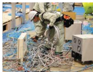
18 撤収の風景その2。LANケーブルだけでなく、電源ケーブルも回収。電源ケーブルは太いので、見た目はスパゲティというよりウドンかもしれない
