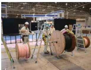
14 NOCに向けて続々と集まっていくバックボーンケーブル類。もちろんNOCは、展示会のインフラとしても大きな役割を果たす
